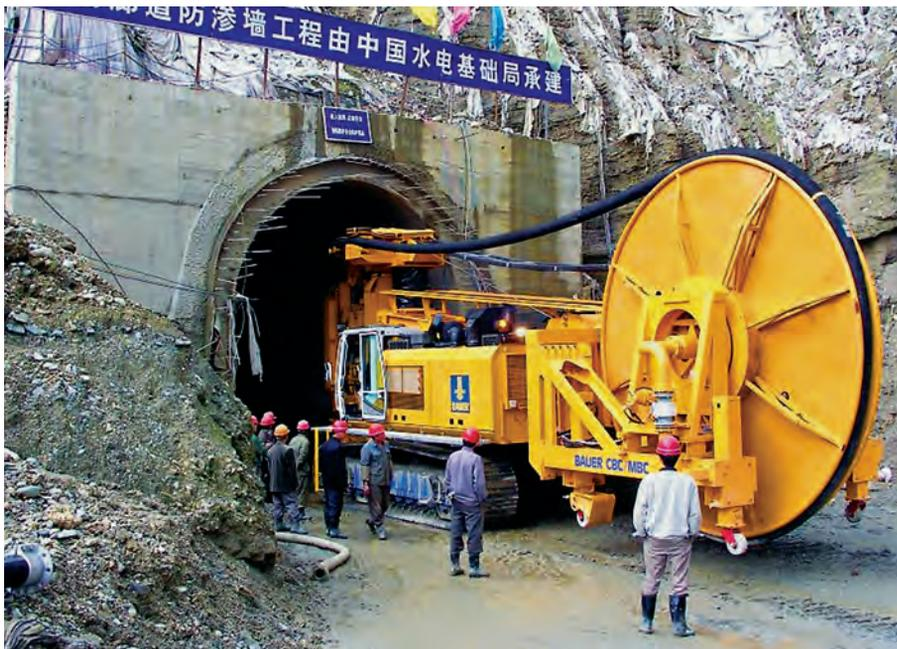
Spezialschlitzwandfräse zum Abteufen einer Dichtwand von 50 Meter Tiefe für einen Staudamm aus einem Tunnel im Norden Chinas 2004. Hans Haberer, Leiter der Maschinenkonstruktion bis 1998 (unten links). Dieter Stetter (zweiter von links), Geschäftsführer der Bauer Technologies Far East in Singapur, mit Kunden auf der Bauma
