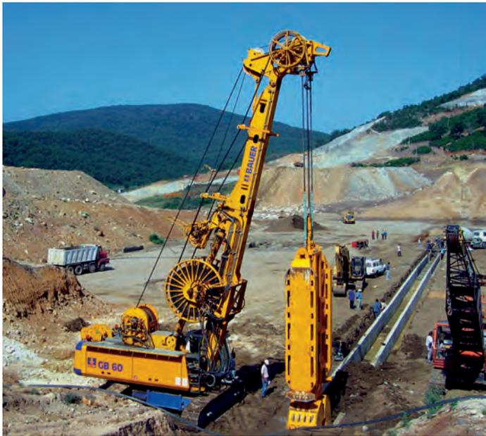
In Tunesien wurden mit Maschinen von Bauer Schlitzwände für das Dammprojekt Tabarka hergestellt
