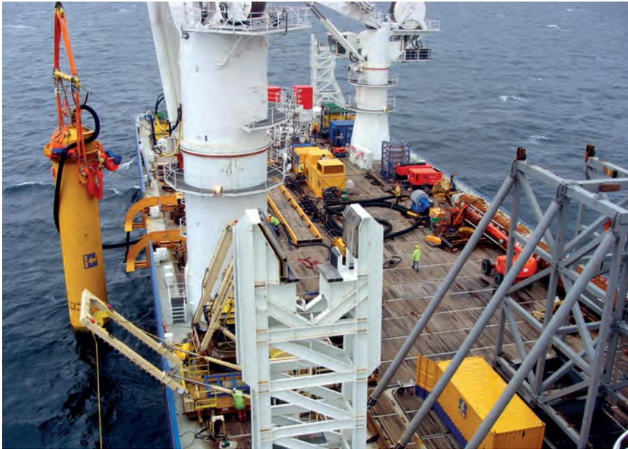
Die Innovationskraft der Bauer-Firmen: Mit einer eigens konstruierten Bohranlage wurde auf dem Meeresboden in der schottischen See ein Monopfahl zur Aufnahme einer Gezeitenkraftturbine niedergebracht
