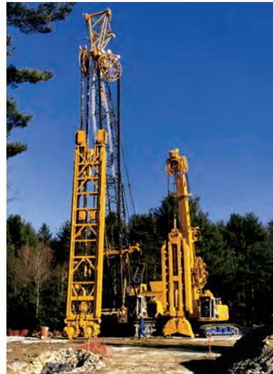
Bau der Straßenstützwand mit Großbohrpfählen am East River in New York 1994.
