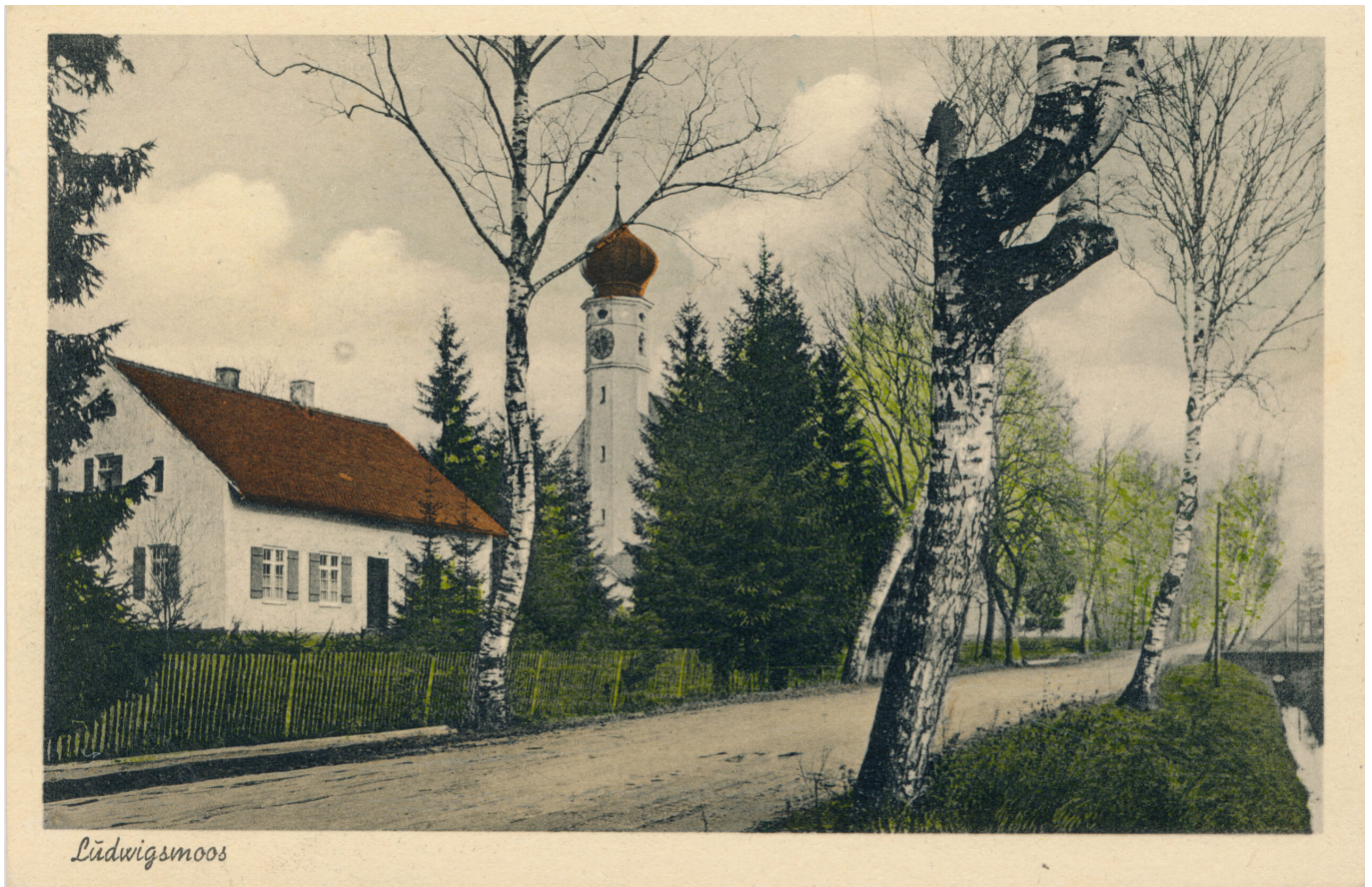
Ludwigsmoos mit Kirche St. Maximilian, Birken und Entwässerungsgraben (um 1930)
